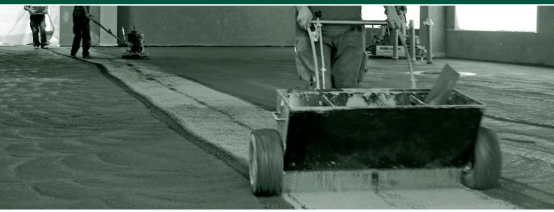
Korodur®-Hartstoffe sind als reiner Hartstoff oder als gebrauchsfertiger, zementgebundener Trockenmörtel auf Hartstoffbasis erhältlich. Um eine optimale Oberfläche zu erhalten, empfiehlt sich die Anwendung einer Verschleissschicht als Hartstoffestrich nach DIN 18560 (siehe Tabelle Beanspruchungsgruppen), die frisch auf frisch (ca. 22 kg/m²) auf den Beton aufgebracht wird.
