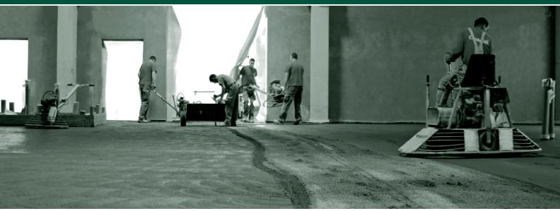
Eine verschleissfeste und gegen Umwelteinflüsse beständige Oberfläche ist ein entscheidender Faktor für eine dauerhafte und wartungsfreie Nutzung des Bodens. Mit Korodur®-Hartstoffen erzeugte Oberflächen gewährleisten überdurchschnittlich gute Biegezug- und Druckfestigkeiten, sehr günstige Abschliffwerte auch bei schwerster mechanischer Belastung sowie eine hohe Beständigkeit gegenüber Umwelteinflüssen.
